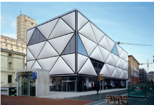
3# Brauen + Wälchli: Aussenansicht der "Miroiterie" / vue extérieure de la Miroiterie, Lausanne (© Thomas Jantscher)
