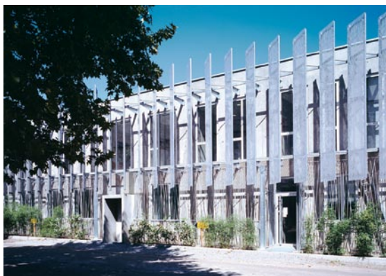
14# Novæ: Fassade des Hauses der Beschäftigung und der öffentlichen Dienste / façade de la Maison de l'Emploi et des Services Publics, Givros (© Jean-Christophe Galmiche)
