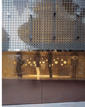
XXXIII_Framing Desire; Façade Detail © Daici Ano
